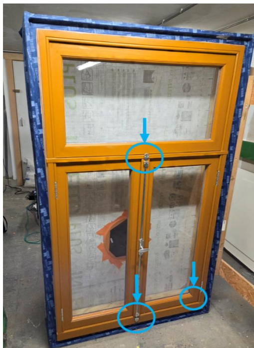
Figure 3. Zones de discontinuité des joints d'étanchéité
